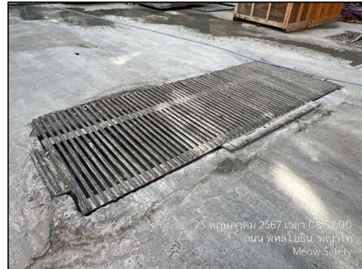
ภาพที่ 32 บ่อตกดินจากการล้างล้อ
